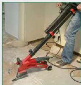
Déposer en poussant à fond sans brutaliser la machine. (Ne pas s'en servir comme un grattoir). Maintenir la lame suivant un angle de 30° et jamais à plat.
