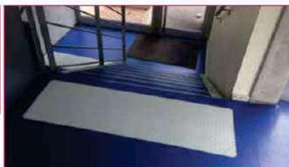
Dalles podotactiles avec pastilles pour créer le contraste visuel et tactile avec le sol.
