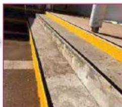
Profil plat antidérapant en polymère époxy impatrisible, de grande durabilité qui ne craint ni l'humidité, ni l'oxydation.
