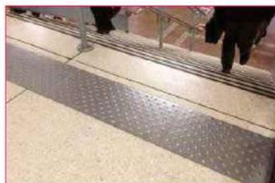
Dispositif tactile et visuel destiné à alerter les personnes aveugles et malvoyantes d'un danger imminent sur leur cheminement. Dalle esthétique en inox brossé 304, tôle épaisseur 1,5 mm emboutie, grain 220 antidérapant. En plus de la fixation par vis, appliquer des cordons de colle polyuréthane en zigzag afin d'atténuer les bruits «clac-clac» lorsqu'on marche dessus. Trous percés-fraisés Ø 3,5 mm pour fixation par vis inox 35 mm non fournies. Poids : 6,5 kg
