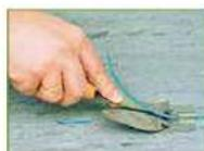
Pré-araçement avec le guide d'araçement lorsque le cordon sera froid, on réalisera l'araçement définitif avec le couteau quart de lune uniquement.
