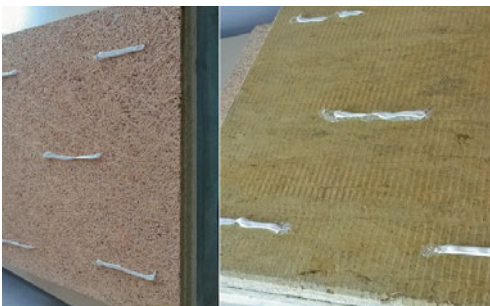
Encoller le dos des panneaux avec 5 cordons de 15 cm
