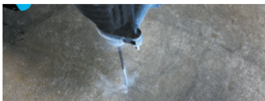
8. Repérage des 2 points de fixation au sol. À l'aide d'un laser reportez l'emplacement des fixations au plafond déjà en place.
