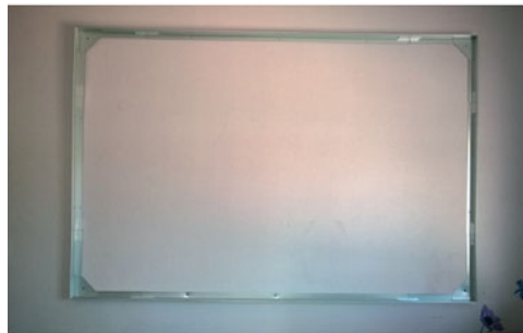
Positionner et fixer le reste des profilés
