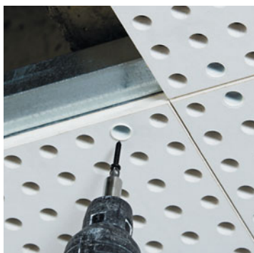
Vissage dans le capuchon
