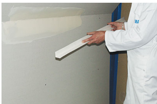
Pose de la bande Ultraflex (angle rentrant)
