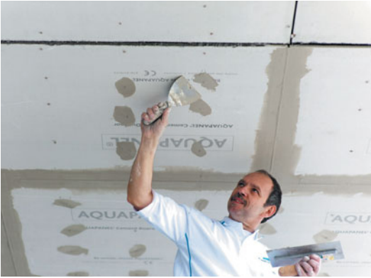
Traitement des têtes de vis
