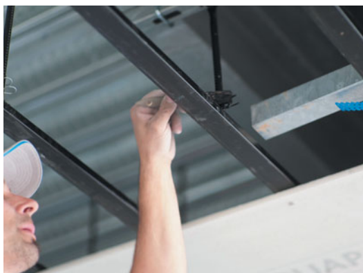
Traitement des goupilles avec peinture anticorrosion
