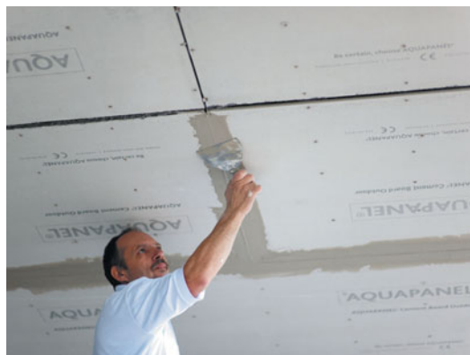
Traitement des joints
