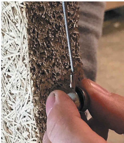
6. Glisser le câble dans les embouts déco latéraux réglables et passe-fil (pour les panneaux de 600 uniquement).
