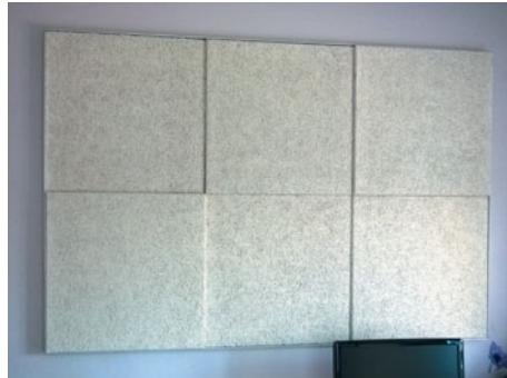
Positionner le panneau dans le cadre en le pressant contre le support
