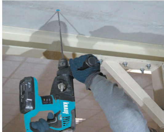
1. Repérage des 2 points de fixation au plafond.
