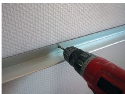
Positionner le profilé de 1 200 sur le trait et percer les 3 trous
