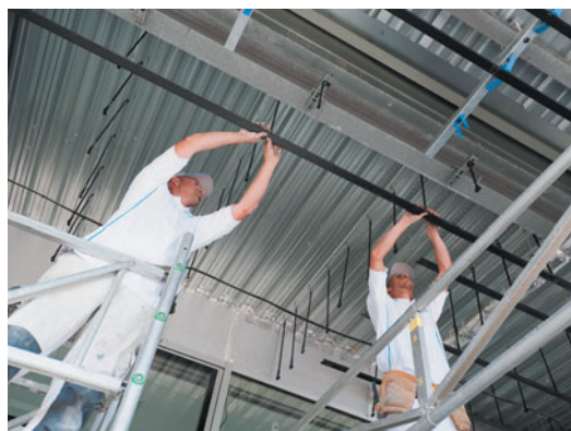
Fixation des fourres F47H
