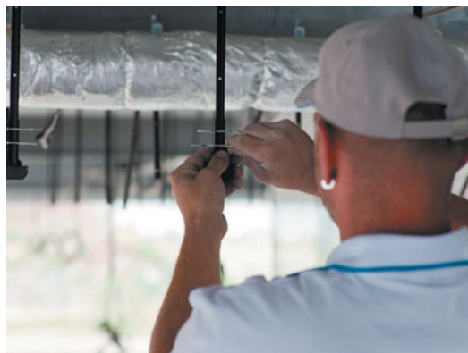
Réglage des suspentes
