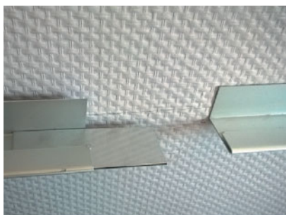
Insérer les éclisses avec le pointeau apparent
