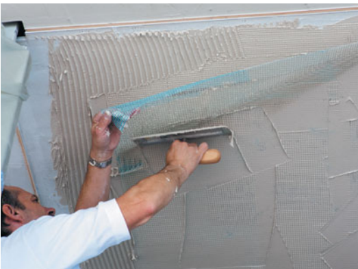
Pose du treillis de renfort
