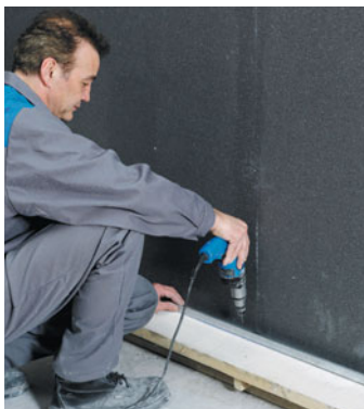
Fixer les rails F47 haut et bas, par chevillage ou pistoscellement.
