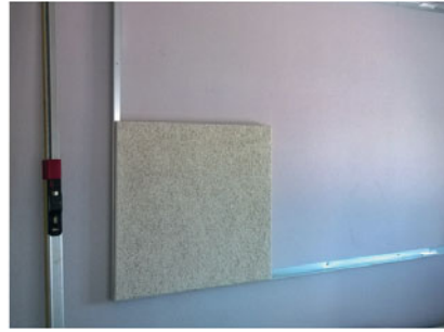
Positionner le panneau dans le cadre en le pressant contre le support
