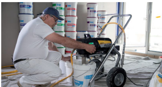
Enduit Knauf Propaint® Dust Control • Pour projection à Airless, réglage de la pression au maximum • Utiliser une buse adaptée à la puissance de la machine et à la quantité que vous souhaitez déposer. • Diamètre mini 0,27 cm. Le léger pommelé pourra être lissé après la projection ou poncé après séchage.
