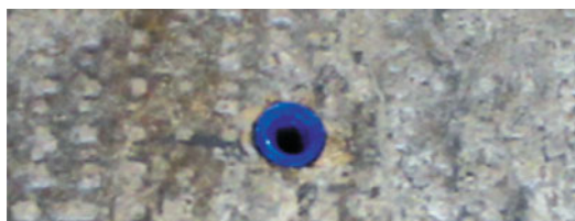
9. Mise en place des 2 chevilles au sol. Choisir le type de cheville en fonction du support.
