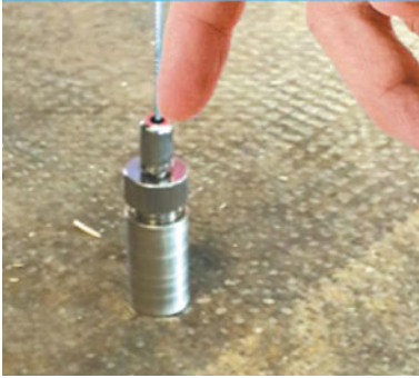
11. Glisser le câble dans l'embout déco réglable (4). Le longueur du câble est à couper au ras du sol. Afin de régler le câble, appuyer sur l'extrémité de l'embout déco réglable. Prévoir une pince coupe câble.
