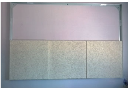
Positionner et fixer le reste des panneaux
