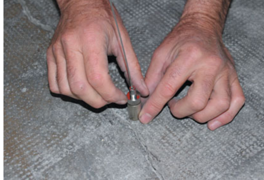
12. Visser l'embout déco réglable (4) sur l'embout déco sol (2) en maintenant les deux parties en même temps afin de tendre le câble.
