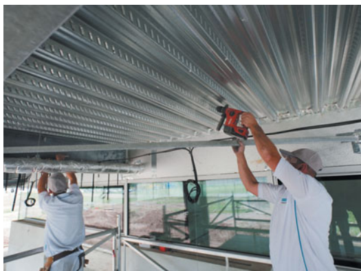
Mise en place des suspentes
