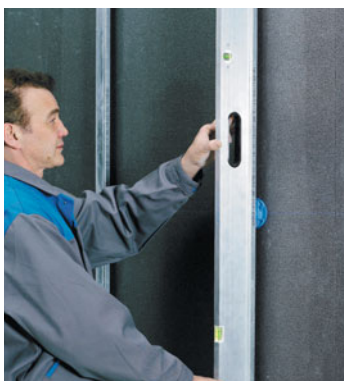
Assembler l'appui Easy Click.
