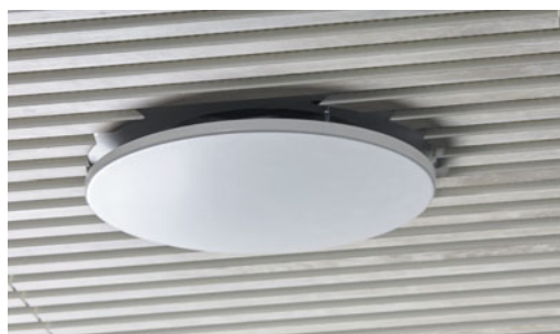
Fig. 9 : Pour les éléments fixés dans le plafond d'un poids à 3kg, une dalle de renforcement doit être installée à l'arrière de la dalle. Une dalle Plaza Régula de 595 x 595 mm reposera à l'aplomb sur les porteurs T24 qui pourront reprendre la charge. Sans dalle de renforcement, il faudra suspendre de manière indépendante l'équipement à intégrer au plafond. Les éléments de plus de 3kg doivent être repris au support de manière indépendante.
