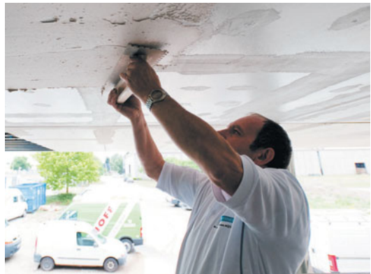
Application de l'enduit d'armature plafond
