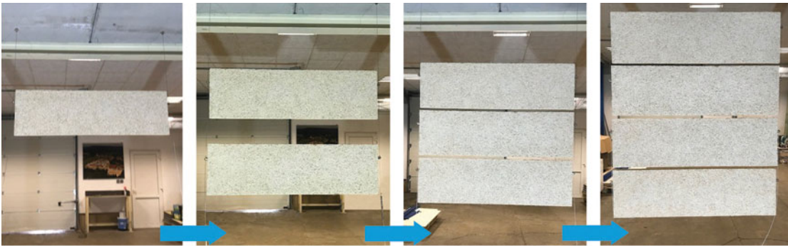
13. Mise en place du nombre de panneaux souhaité sur les câbles.
