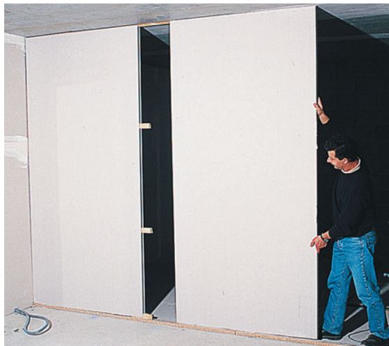
Fig. 2 : Jonction entre deux cloisons
