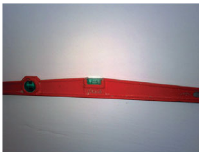
Tracer la ligne basse à l'aide d'un niveau
