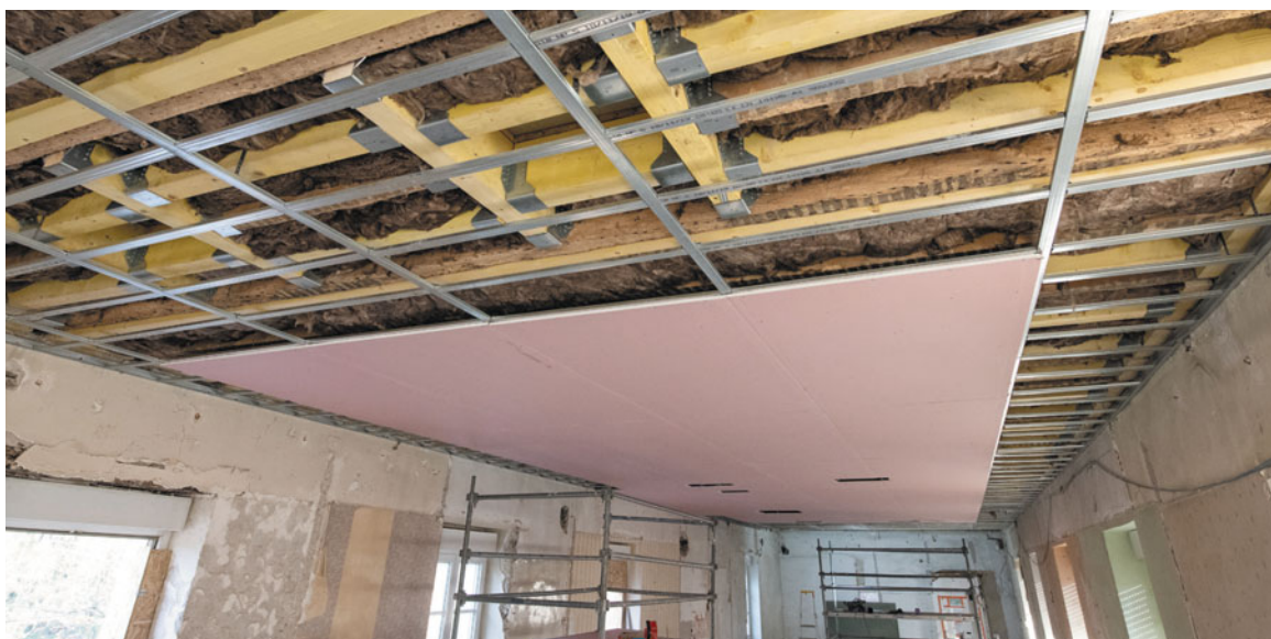
Bâtiment ancien ERP - Nantes (44) Entreprise de pose : MGP Staff (44)
